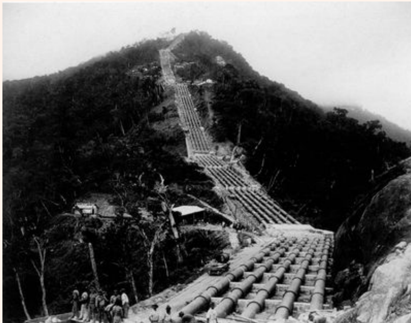
Construção de hidrelétrica em Itatinga (SP).
